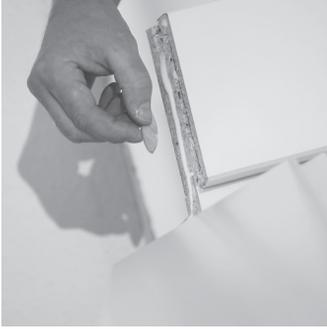
Enduire généreusement de colle les surfaces de coupe en onglet des parties du dormant. Insérez le lamello fourni dans la rainure préalablement fraisée
