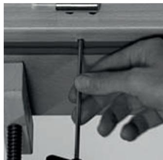
Posez les parties du cadre dans le dormant et ajustez avec la clé Allen. Les paumelles et les parties du cadre pour éléments affleurants sont montées sur la porte à l'usine. Pour les paumelles 3 pièces, reliez les parties du cadre et d'aile et insérez les dans le logement de paumelle.
