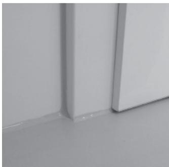
Pour protéger le dormant de l'humidité - comme l'eau de nettoyage, le raccord au sol doit être scellé sur les sols en grès ou en bois. Pour ce faire, utilisez un silicone durablement élastique standard.
