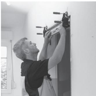
Pour la fixation, posez deux éclisses d'alignement de dormant (en alternative, cales) sur la plaque supérieure du dormant. Vérifiez l'alignement perpendiculaire et horizontal du dormant.
