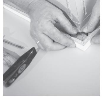
Insérez l'excentrique dans le fraisage et serrez l'étrier de serrage au moyen d'un tournevis.
