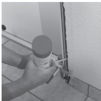
Moussez généreusement le dormant à hauteur des trois écarteurs sur toute l'épaisseur du mur avec une mousse bicomposants standard.
