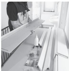
Contrôlez l'épaisseur et l'ouverture murale et comparez les avec les données figurant sur le carton du dormant. Contrôlez l'intégralité et l'intégrité du matériel. **Pour les pièces montées, toute réclamation est exclue.**
